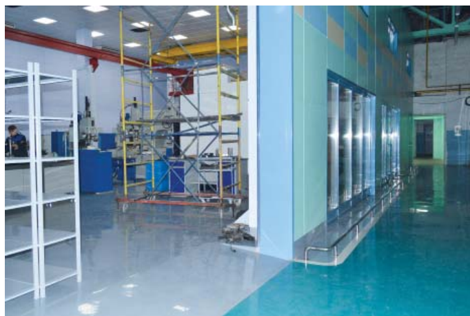
Возведение двухэтажной административно-производственной части
