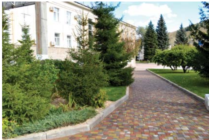
Дорожка, вымощенная тротуарной плиткой
